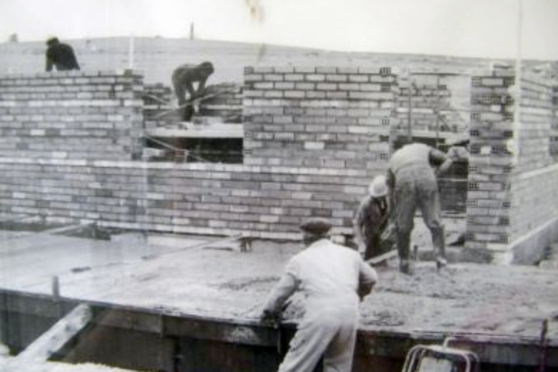
Los propios socios trabajaron en la construcción de las instalaciones.
