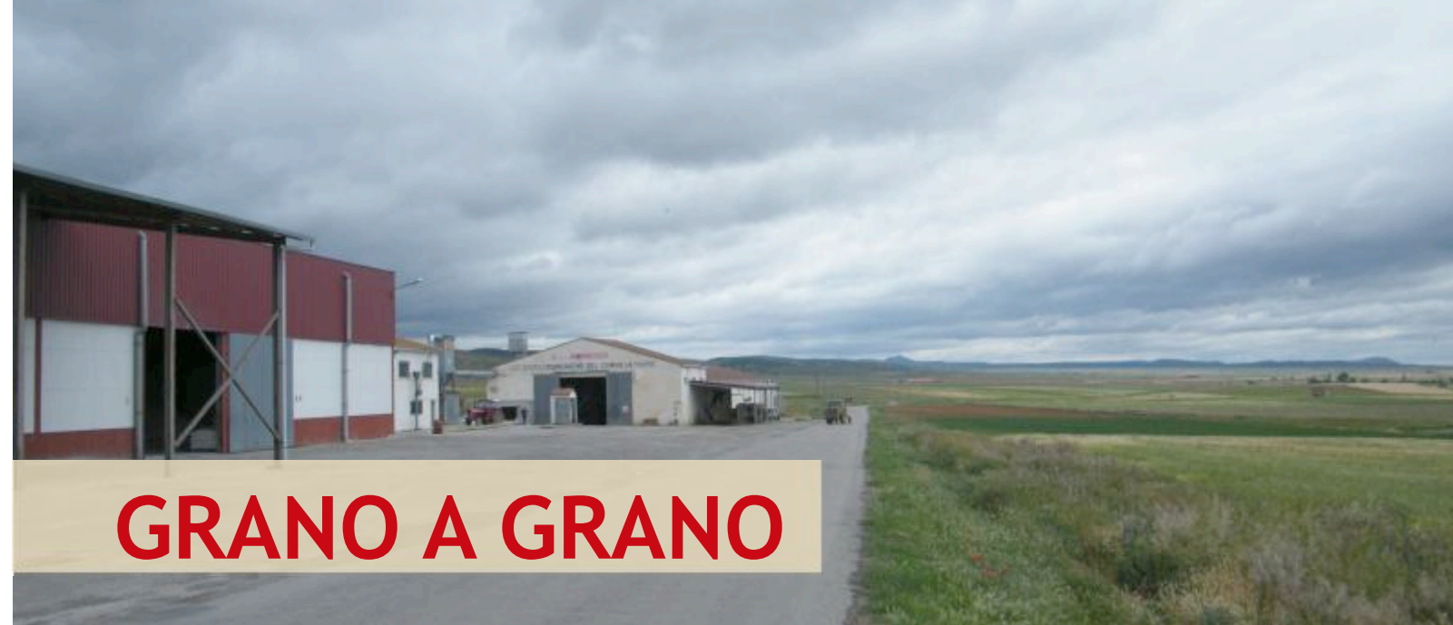
Instalaciones de lo Cooperativa de la Fuente de Cella.
